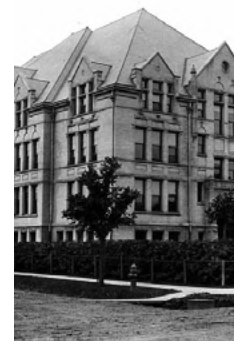
Fig. 9. North Community High School, Minneapolis, Minnesota, 1914-1973. Beal a fréquenté cette école dans les années 1890.
